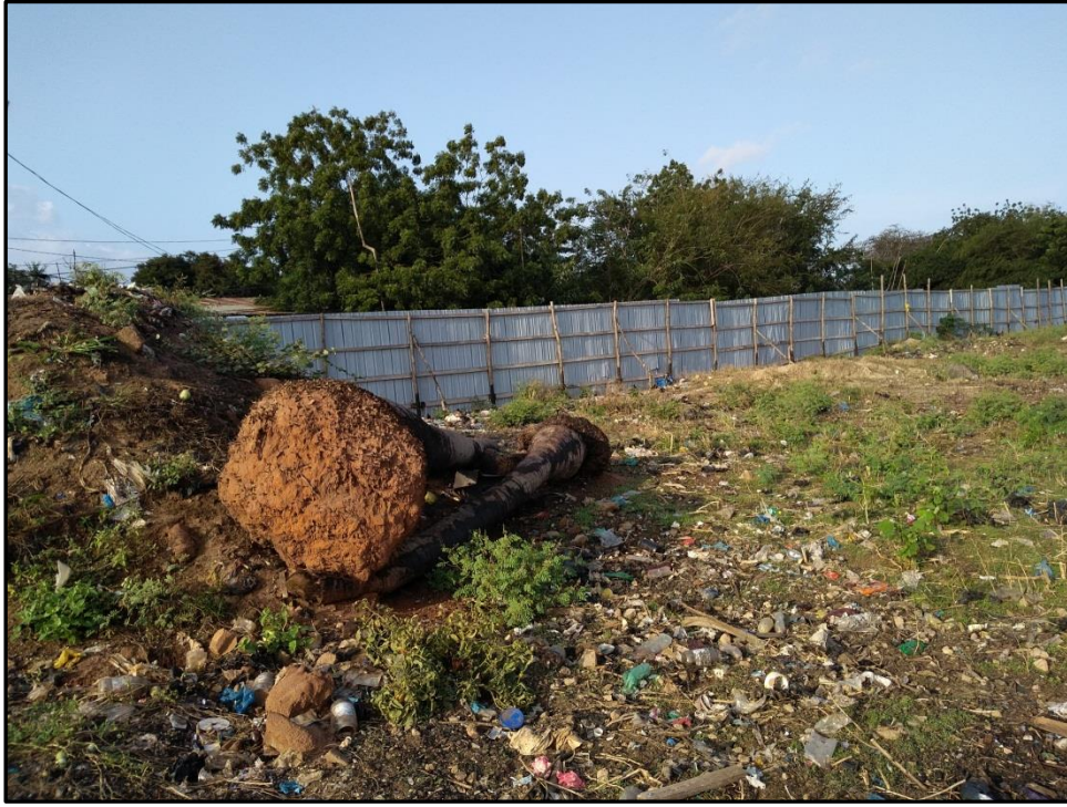
Photo 3: Vue de troncs de cocotiers abattus sur le site Source : SECDE, septembre 2020
